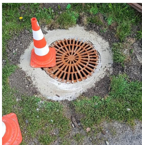
Opravená vpust' u Vrbového
