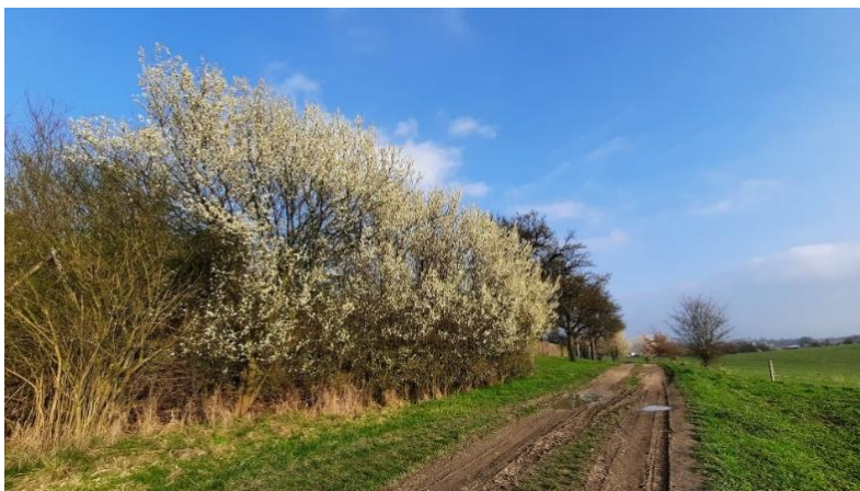
Komunikace směrem k rybníku před opravou
