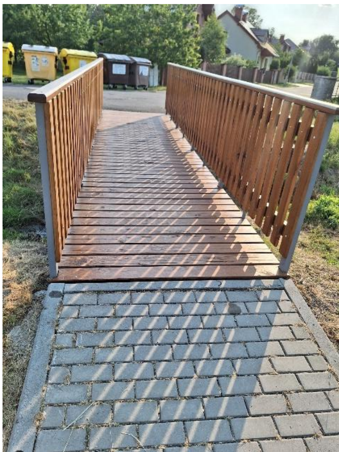
Opravená lávka u hřiště
