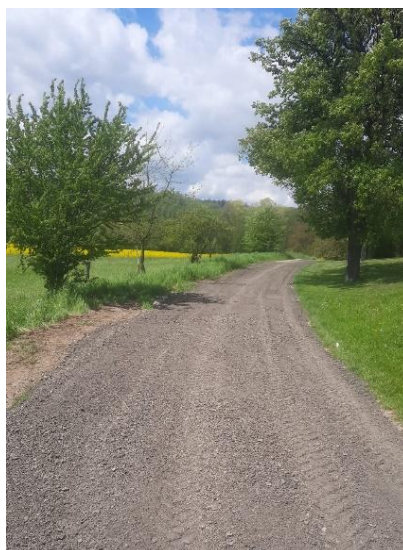
Komunikace směrem k rybníku po opravě
